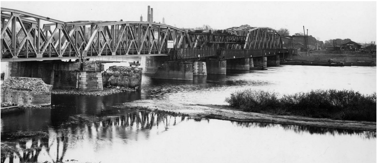
Ilustracja nr 14.:Rozbiórka resztek starego mostu, 1926 rok. Pocztówka ze zbiorów Marka Wichrowskiego.
