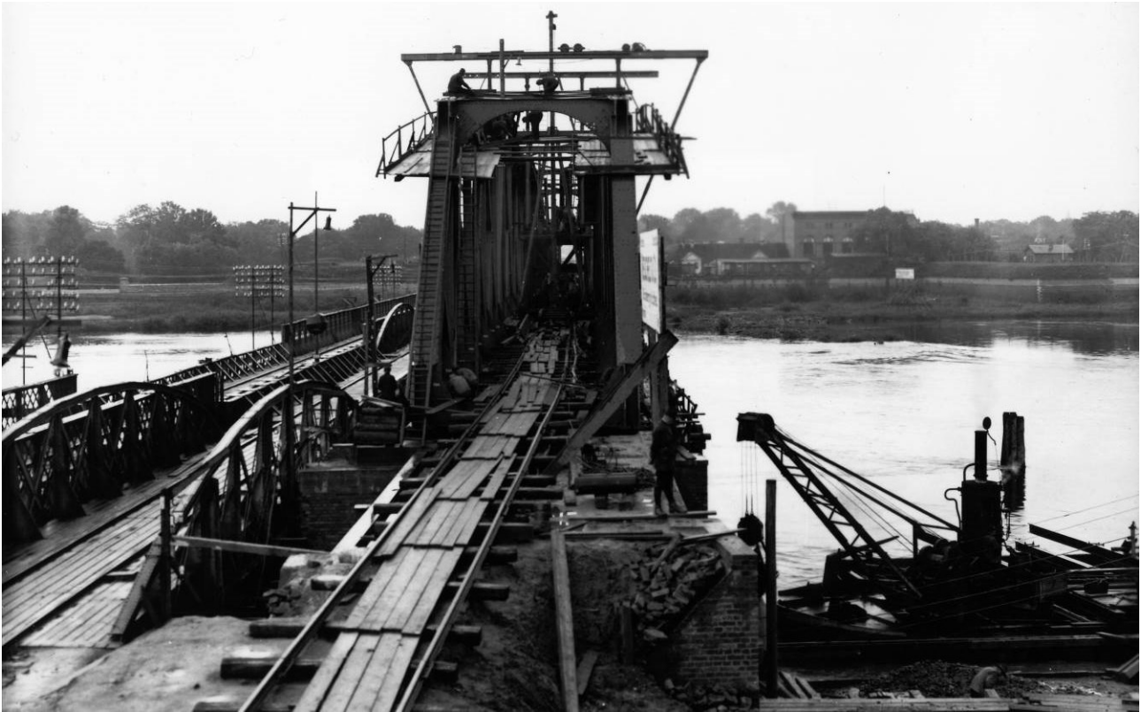
Ilustracja nr 13.:Budowa pierwszej nitki nowego mostu obok starej konstrukcji z czasopisma Die Bautechnik z 1927 roku 20 .
