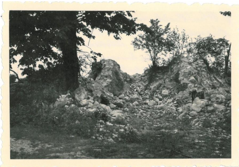
Fot. 4. Hałda gruzu z niewielkimi pozostałościami murów dawnego kościoła zamkowego. Tak to wygląda prawie wszędzie na Starym Mieście. Wspięliśmy się nad nią, aby rozpoznać przebieg jakiegokolwiek ulicy. Niestety na próżno. Brama Berlińska wciąż była dla nas najlepszym punktem orientacyjnym. Na lewo od Bramy Berlińskiej około 80-100 szerokich stopni schodów prowadzi do pomnika chwały.
